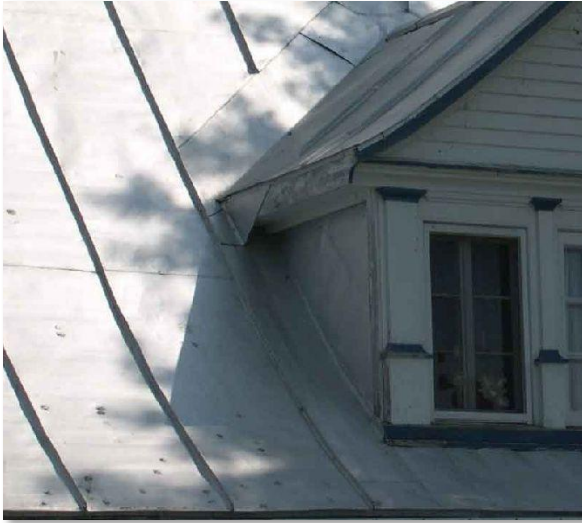
Figure 15 – Toiture en tôle pincée ou agrafée
