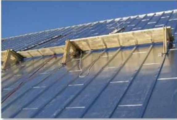
Figure 13 – Toiture en tôle à baguette
