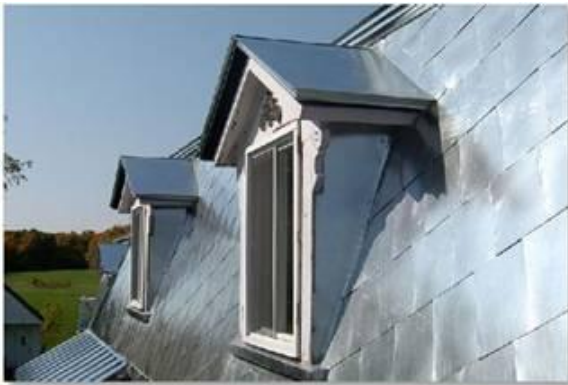
Figure 14 – Toiture à la canadienne
