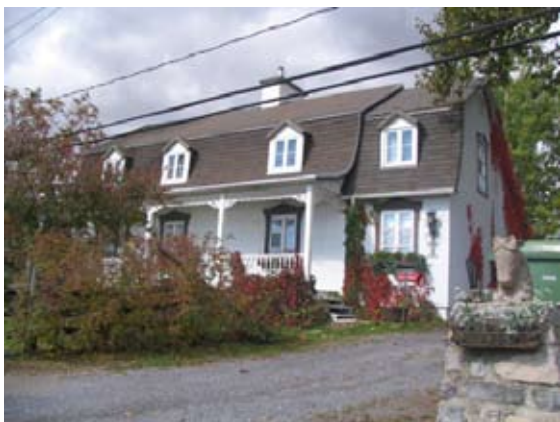
Fig. 25 : Toiture mansarde
