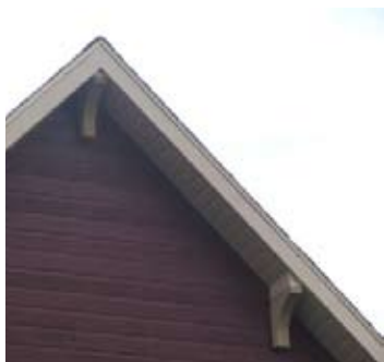
Fig. 128, 129 et 130 : Respectivement, modèles de corbeaux s'intégrant à la maison champêtre et/ou de villégiature, et alpine.
