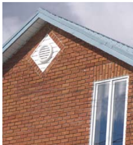
Fig. 59 : Détail d'appareillage de la brique en soldat
