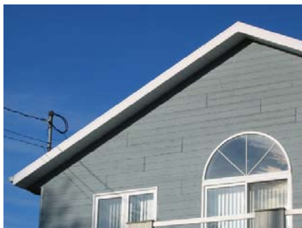
Fig. 64 : Joints verticaux très apparents sur un panneau double
