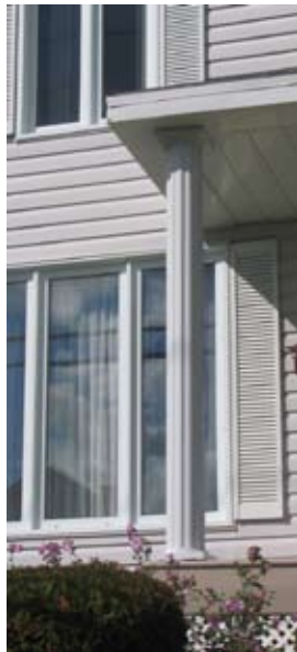
Fig. 101 : Poteau métallique
