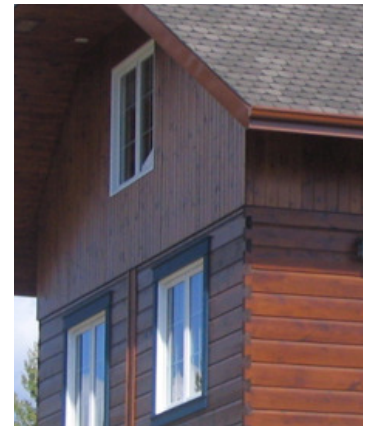
Fig. 53 : Orientation et profil différents des revêtements de bois
