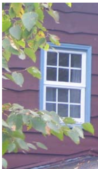
Fig. 70 : Fenêtre à guillotine à six carreaux par section
