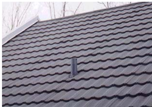
Fig. 41 : Tuiles ondulées
