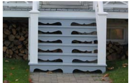
Fig. 111 : Modèle de contremarche simple à réaliser
