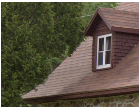
Fig. 29 : Bardeaux d'asphalte de modèle traditionnel
