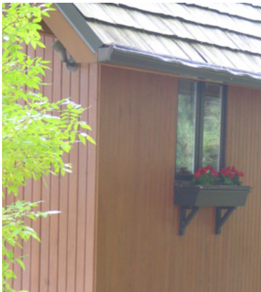
Fig. 51 : Revêtement de bois vertical d'environ 6 po
