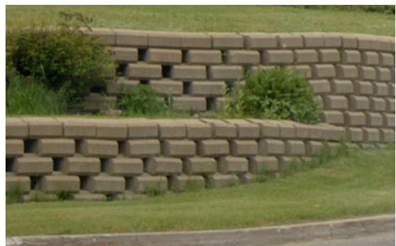
Fig. 152 : Murets d'interblocs à éviter
