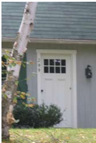
Fig. 82 : Porte en bois avec montants et traverses formant des caissons
