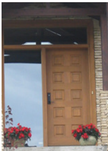
Fig. 85 : Modèle de porte simple avec impostes
