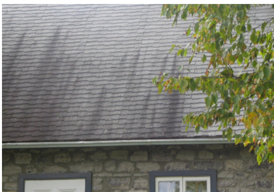
Fig. 31 : Bardeaux d'asphalte de couleur claire démontrant les risques de formations de coulisses noires
