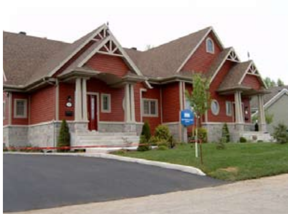
Fig. 21 : Volumétrie de chaque unité différente et éléments en saillies modulant la façade principale
