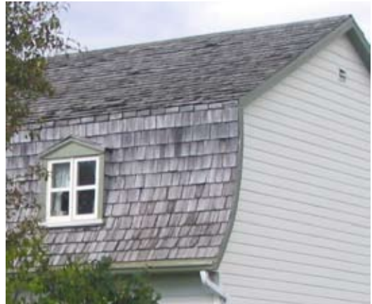
Fig. 34 : Bardeaux de cèdre très texturés s'intégrant parfaitement sur une maison champêtre
