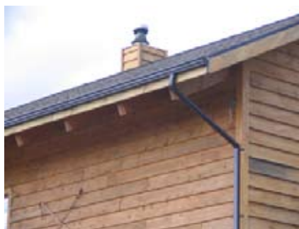
Fig. 131 et 132 : Poutres et chevrons apparents s'intégrant à la maison de villégiature et alpine
