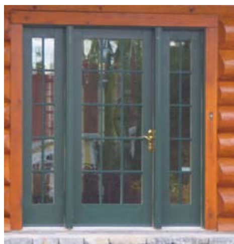
Fig. 87 : Modèle de porte simple avec impostes latéraux
