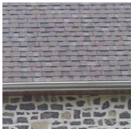
Fig. 30 : Bardeaux d'asphalte de modèle imitant le bardeau de cèdre
