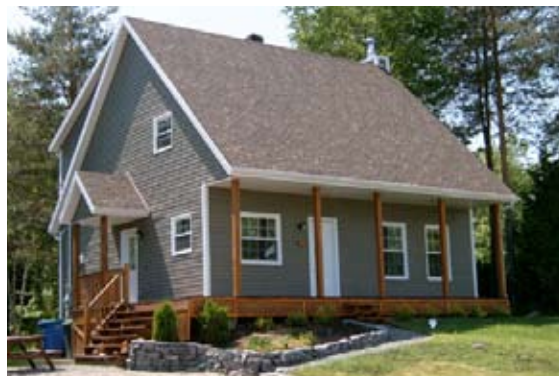
Fig. 96 : Galerie couverte par le prolongement de la toiture principale
