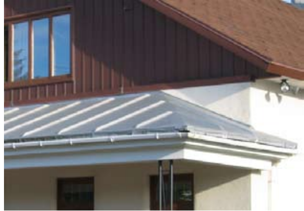
Fig. 37 : Toiture de tôle à baguettes
