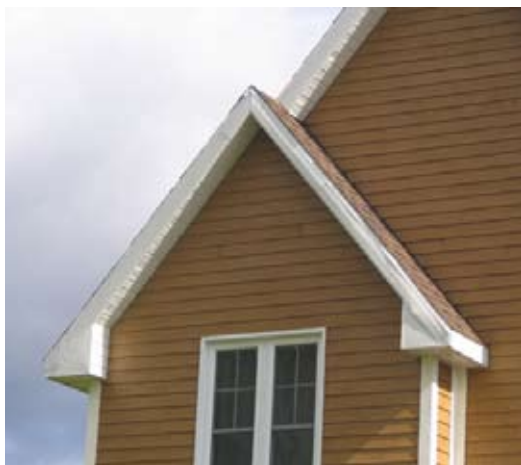
Fig. 63 : Joints verticaux du modèle simple
