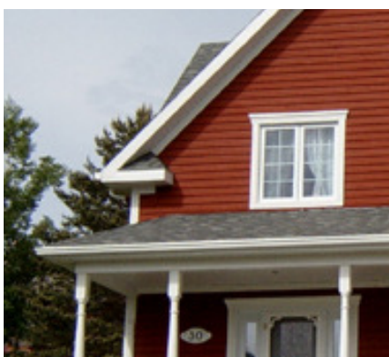
Fig. 43 : Retour de toiture
