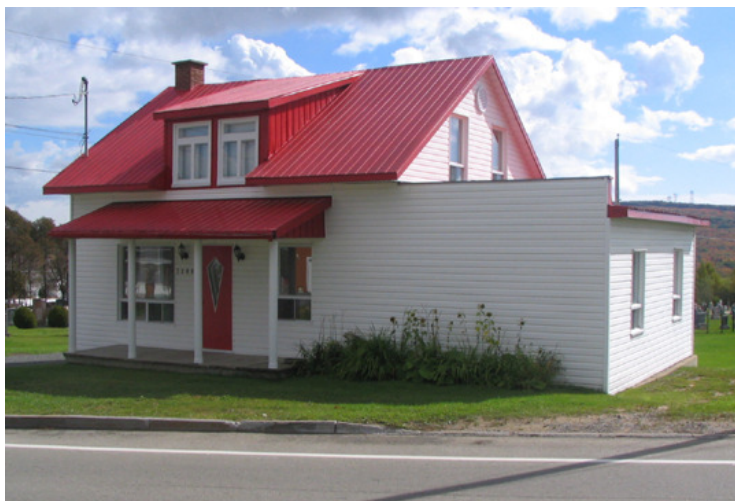
Fig. 115 : Annexe altérant le volume principal de la maison par entre autres, l'absence d'un retrait entre le mur de la maison et celui de l'annexe
