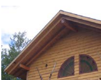
Fig. 131 et 132 : Poutres et chevrons apparents s'intégrant à la maison de villégiature et alpine
