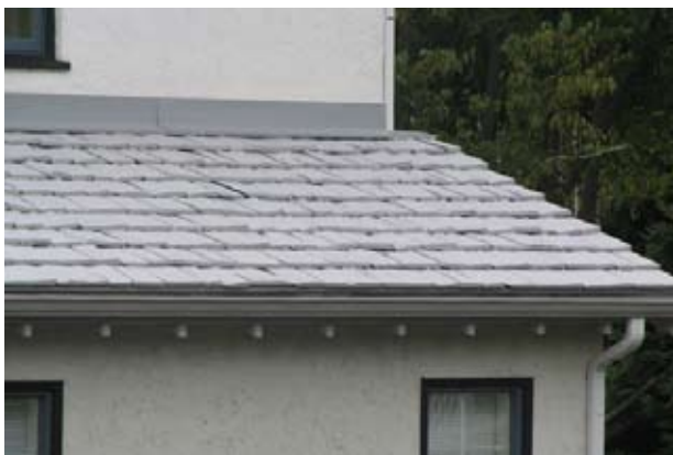
Fig. 35 : Bardeaux de bois recouvert d'une couleur opaque
