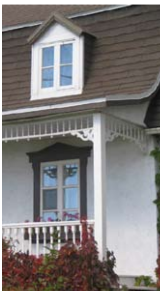
Fig. 69 : Fenêtre à deux ou trois carreaux par battant
