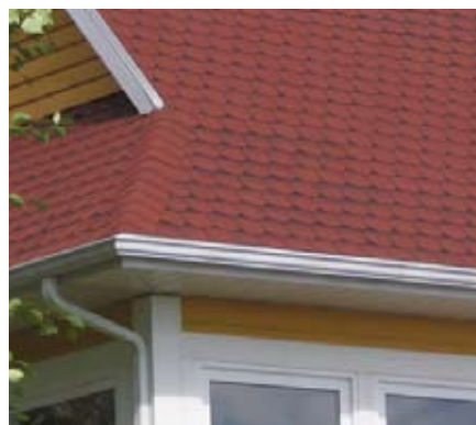
Fig. 32 : Bardeaux d'asphalte de modèle complexe attirant l'attention
