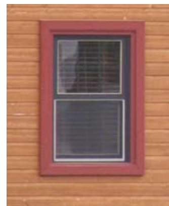
Fig. 120 : Encadrement simple et de couleur différente au parement s'intégrant parfaitement à la maison de villégiature ou alpine
