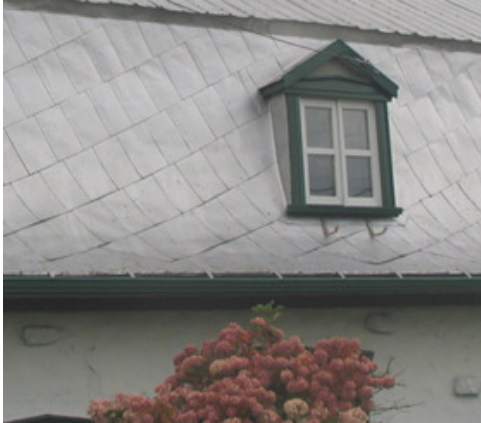
Fig. 36 : Toiture de tôle à la canadienne
