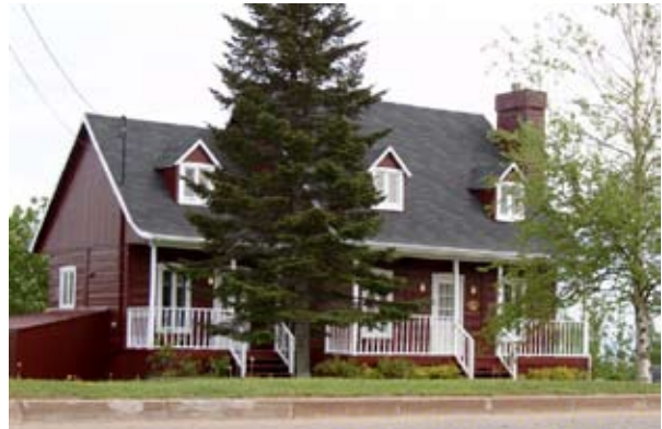
Fig. 24 : Toiture à deux versants de pente forte
