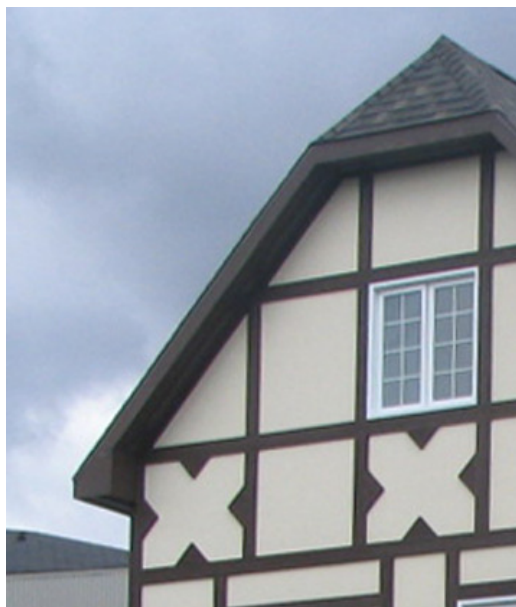
Fig. 62 : Panneau de fibro-ciment remplaçant le crépi
