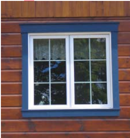
Fig. 72 : Fenêtre à battants avec faux carreaux
