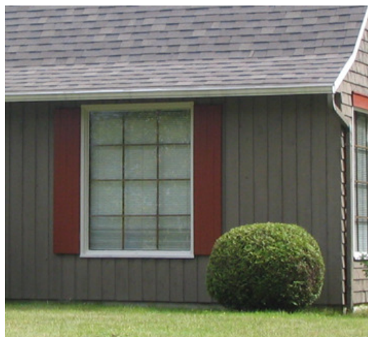
Fig. 122 : Volet de largeur insuffisante pour la fenêtre
