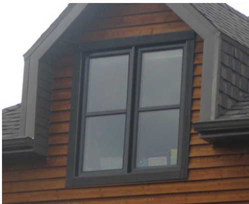
Fig. 74 : Fenêtre à battants imitant la fenêtre à guillotine
