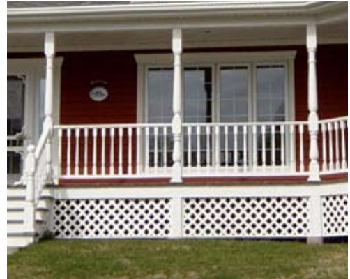
Fig. 110 : Sections de treillis alignées avec les poteaux de la galerie
