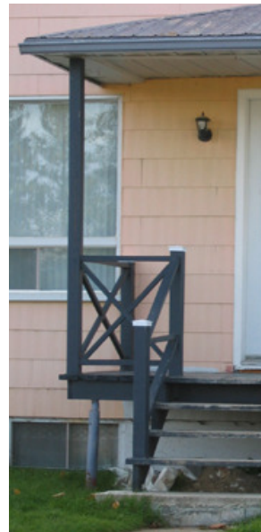
Fig. 102 : Poteau de 4 po trop étroit
