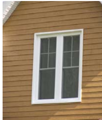
Fig. 73 : Fenêtre à battants avec faux carreaux
