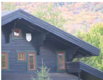
Fig. 128, 129 et 130 : Respectivement, modèles de corbeaux s'intégrant à la maison champêtre et/ou de villégiature, et alpine.
