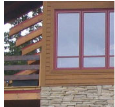
Fig. 76 : Fenêtre à battants reproduisant la fenêtre à auvents
