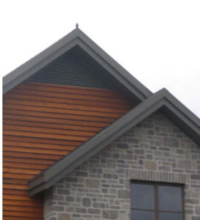
Fig. 46 : Évent intégré à la façade et fascia harmonisé
