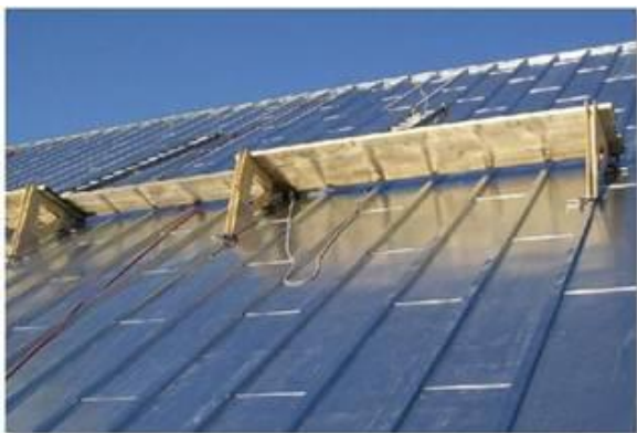
Figure 13 – Toiture en tôle à baguette
