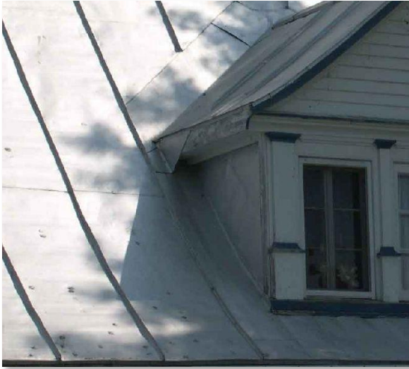
Figure 15 – Toiture en tôle pincée ou agrafée
